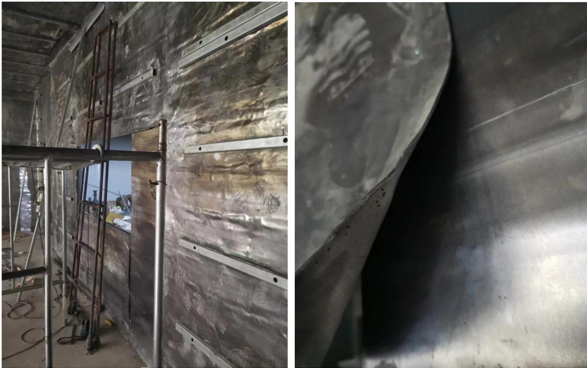
图 3-1 新建 2 号介入室机房墙体四周、屋顶铅板施工现场图
