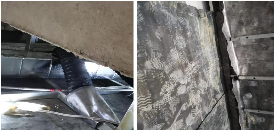
图 3-2 新建 2 号介入室通排放风管道、屋顶铅板施工现场图
