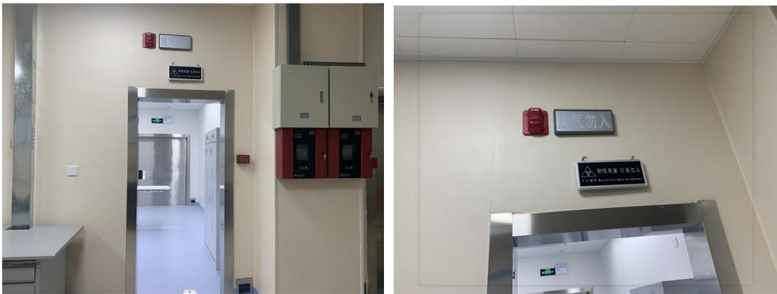
图 3-4 新建 2 号介入室医生通道防护门（门灯联锁装置及工作状态指示灯）
