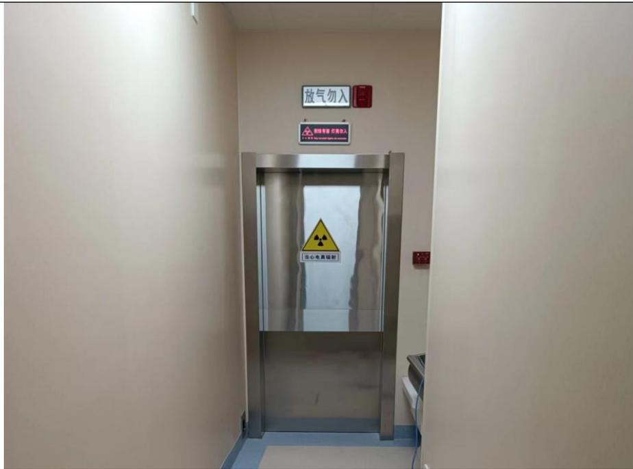
图 3-6 新建 2 号介入室污物通道（门灯联锁装置及工作状态指示灯）
