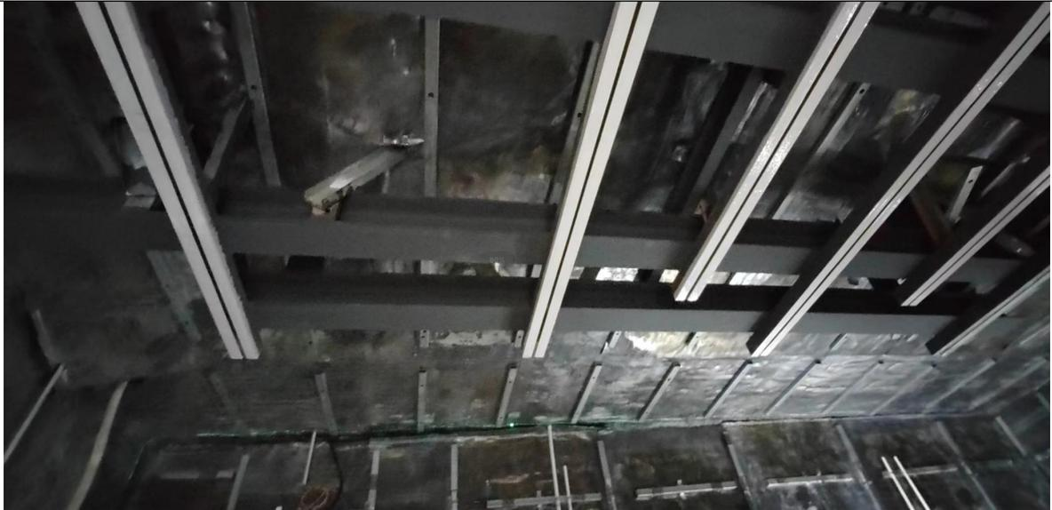
图 3-3 新建 2 号介入室屋顶铅板施工现场图
